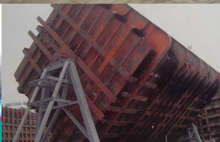
Le réservoir en acier de chemise rectangulaire entreprise moulage par rotation sur place d'un arsenal, préparation à l'emmanchement en tant qu'array de réservoirs comme ceci dans un navire.
